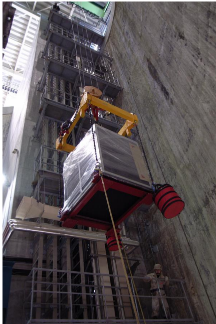
図 5.3: モジュールのピット内へのインストール作業
