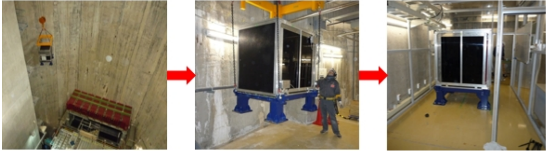
図 16 B2 モジュールの設置する様子と設置場所
