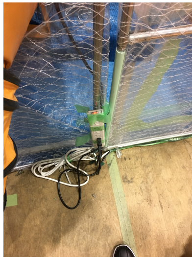
図 3.33 電源関係. 漏水した場合に電源タップが水没しないように少し上に取り付けている.
