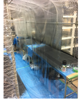
図 3.7 作業場所内部
